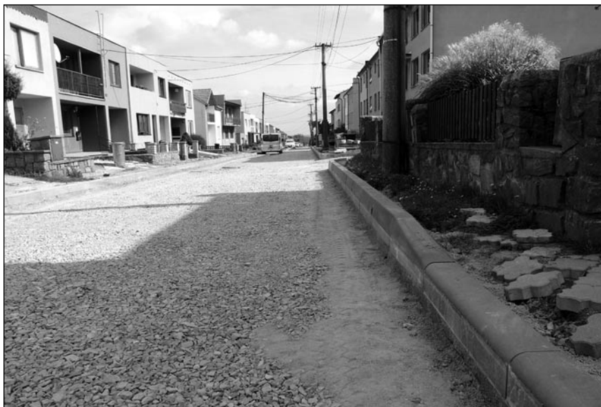
Oprava ulice Nová
