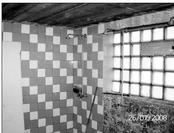
Nově zbudovaná kabina rozhodčích z původních sprch
