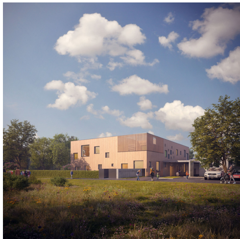
Pohled z jihovýchodu
